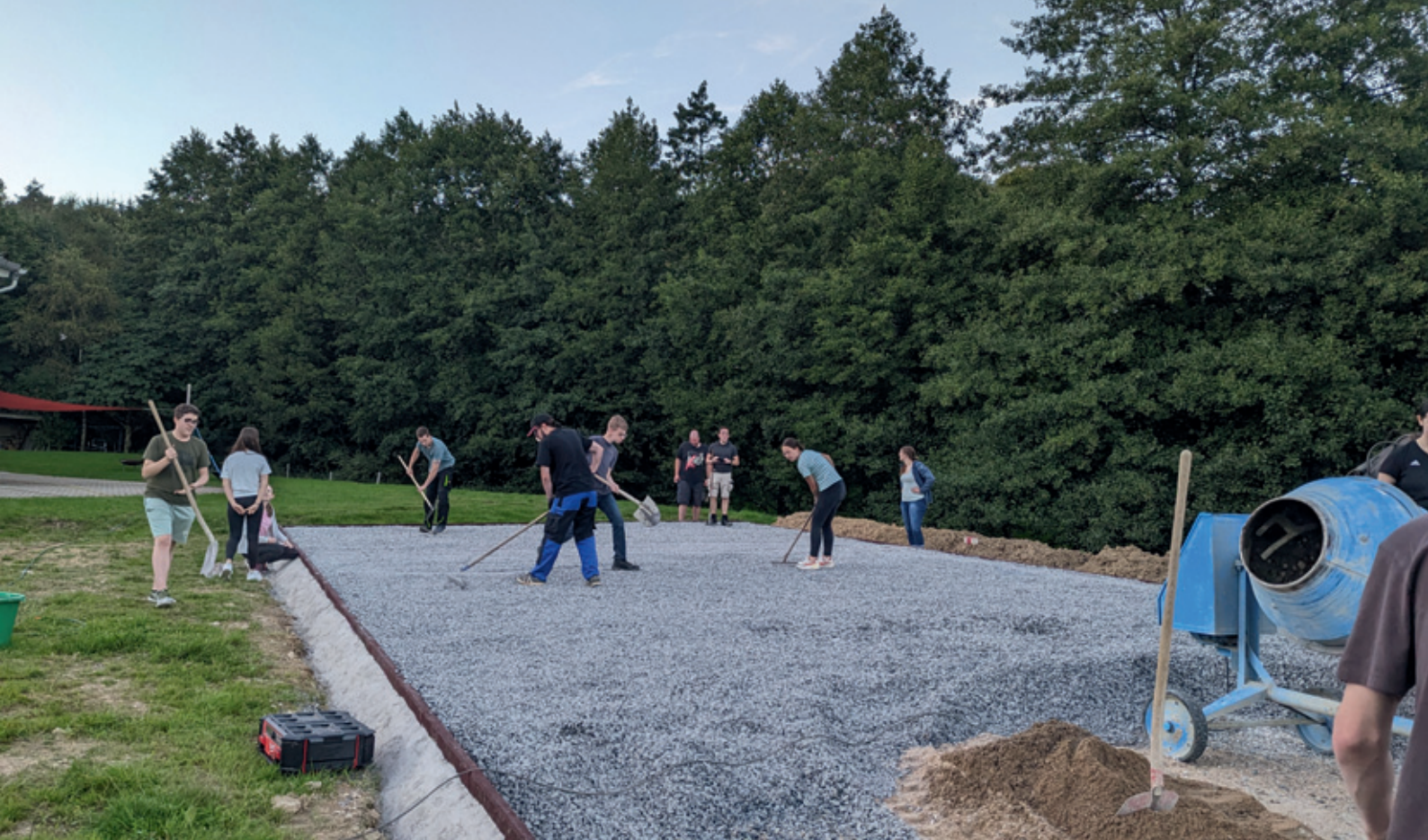
Bau eines Freiluft-Spielfeldes durch die Jugendgruppe der FeG Hilchenbach-Lützel
